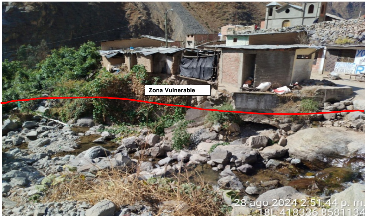
FIGURA N°02: SE OBSERVA LA MARGEN DERECHA DE LA QUEBRADA EL CUAL ES VULNERABLE ANTE UNA CREDIDA, POR DICHO LADO SE ENCUENTRA COMPLETAMENTE EROSIONADA.
